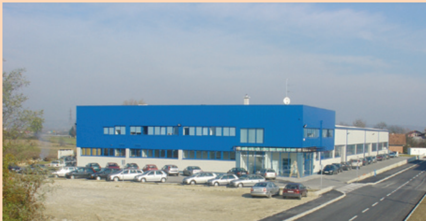
Proklima - nova poslovna zgrada
